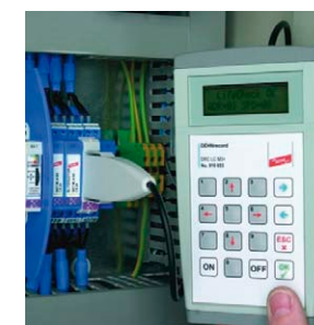
Рис. 5. ЩУЗИП на базе УЗИП BLITZDUCTOR XT Ex(i) и корпуса ALGA 5 X
