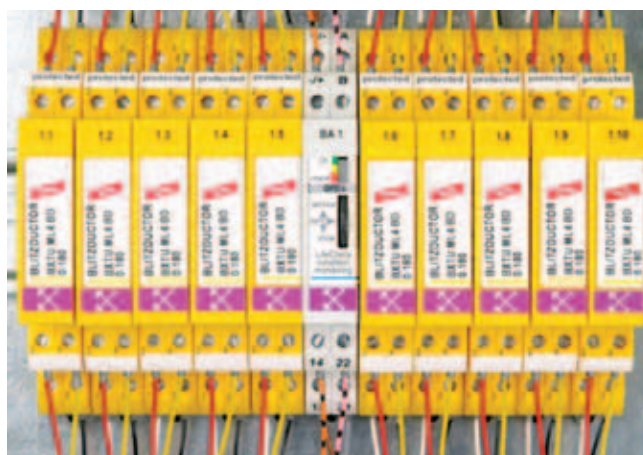
Рис. 2. Переносной тестер DRC LC M3+ и стационарный блок мониторинга DRC MCM XT для контроля состояния до 10 сменных модулей УЗИП BLITZDUCTOR XT
