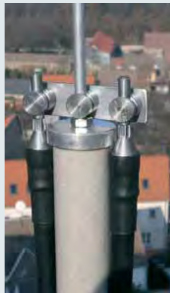
HVI® проводник – параллельное подключение с помощью клемм Арт. № 301329.
