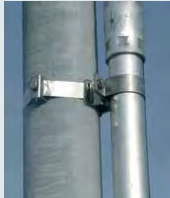
Фиксирующий зажим со стяжным хомутом для крепления на опорной трубе.
