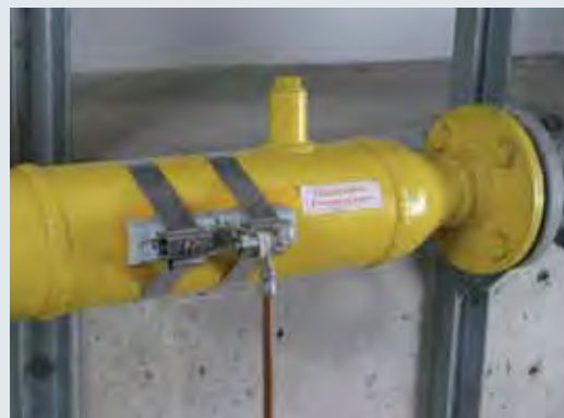
Рис. 1: Ленточный хомут для включения труб во взрывоопасных зонах в систему молниезащитного уравнивания потенциалов согласно DIN EN 62305-3 (VDE 0185-305-3)
